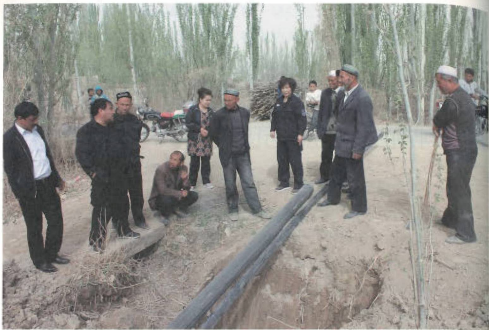
现场指挥协调安装灌溉水管
