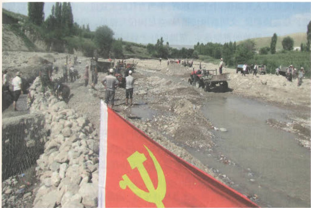
党员带领群众修建防洪坝
