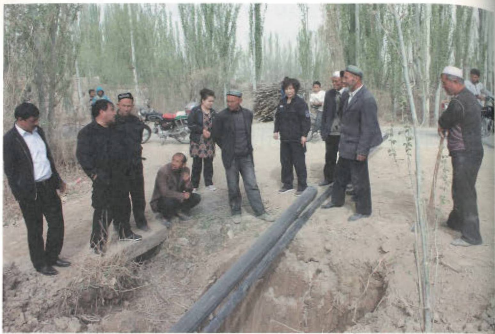
现场指挥协调安装灌溉水管
