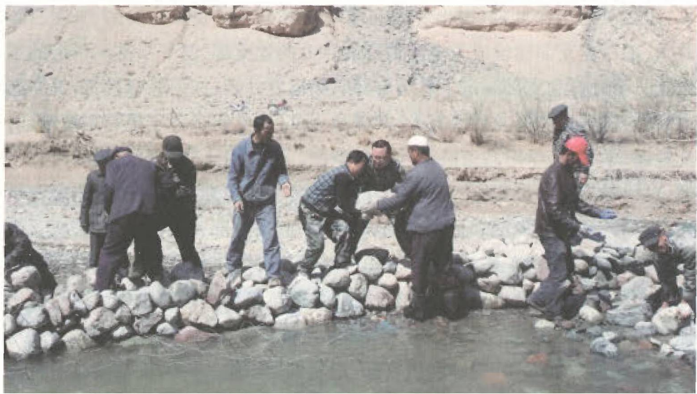
工作组成员与村民一起修建水利工程,搬运石头维修防洪坝。
